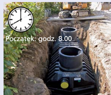
Przykład montażu oczyszczalni ścieków dla 6 RLM
