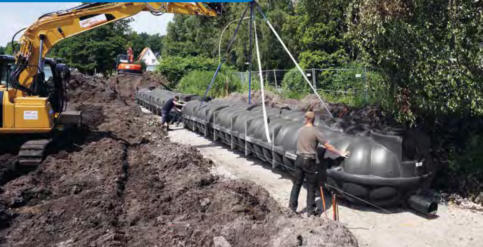
Einbaubeispiel: Retentionsanlage NEO 4 x 25.000 Liter
